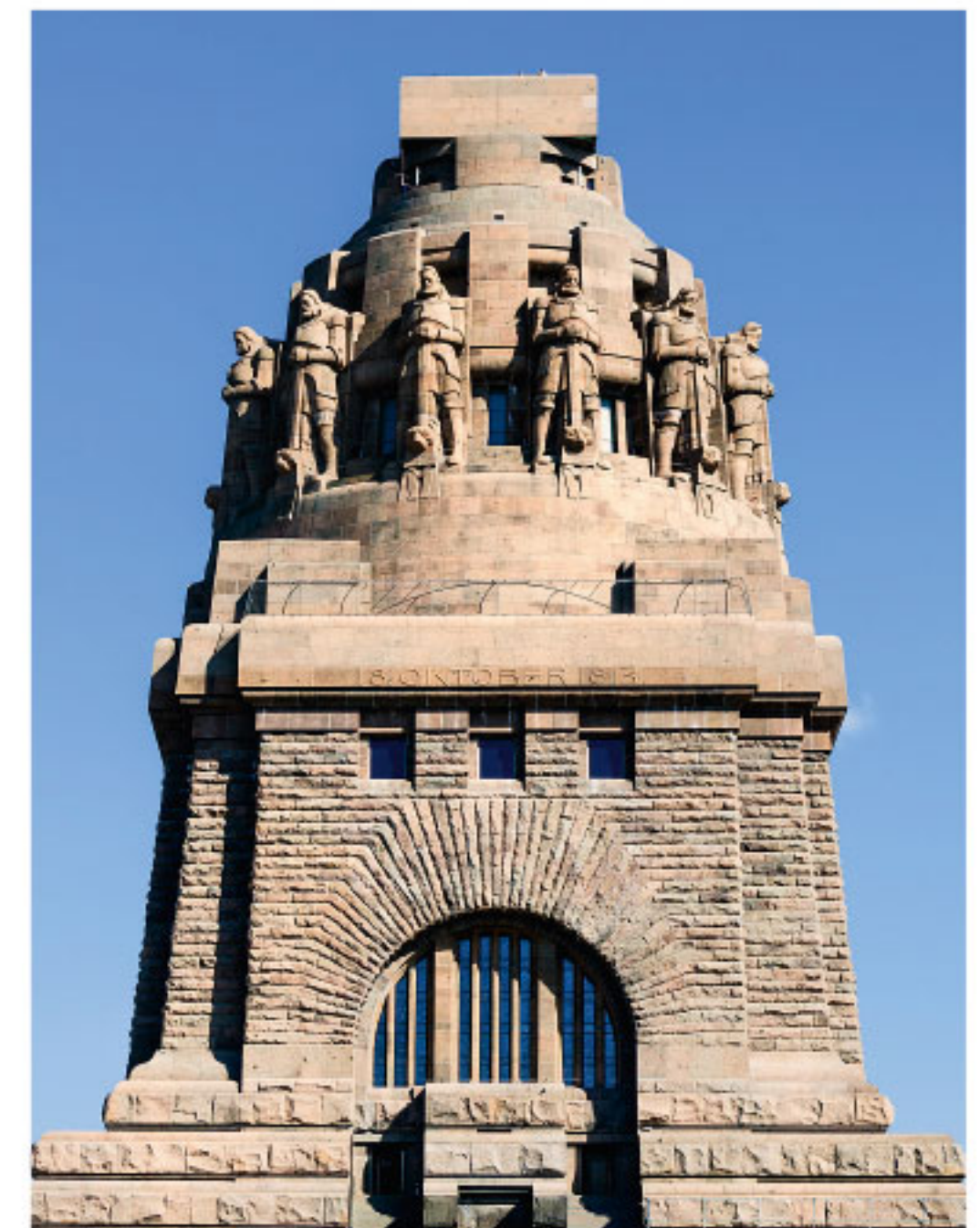
Abb. 48 Der Bau des Völkerschlachtdenkmals in Leipzig ruhte auf dem finanziellen Fundament einer Lotterie.
